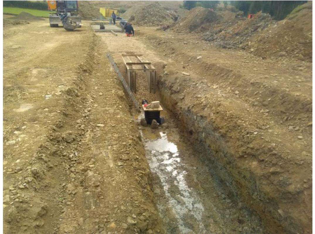
Bild: Sanierung der Quelfassungen in Lotten/Rocherath
