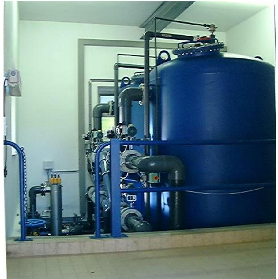
Bild: Filteranlage der TWA Büllingen/ Rotheck
